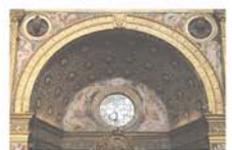
Volta a botte con decorazioni in stucco, affreschi e occhio con struttura in piombo.
