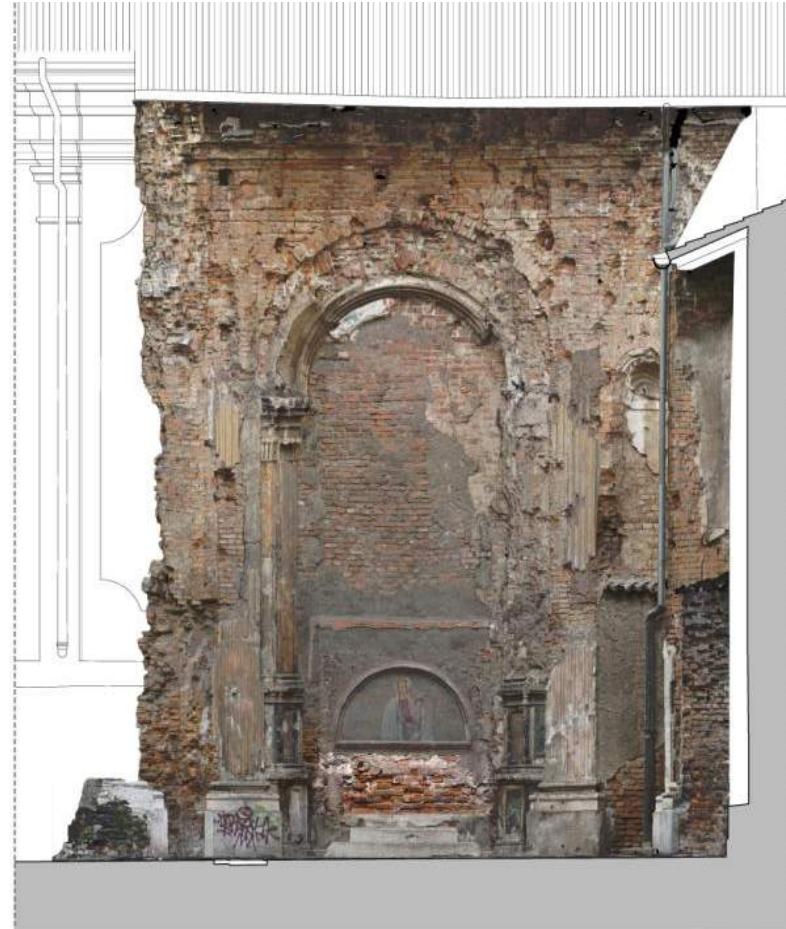
Restituzione fotografica bidimensionale - fotoraddrizzamento
