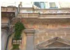
In questa fotografia è immediatamente visibile la presenza di vegetazione cresciuta ad altezza del fregio e al di sotto di essa a diversa altezza colonizzando le loggiate. La colonna al primo piano coperta da un deposito superficiale di polveri, mentre le metope al rigliolo sono interamente disgregate. Si nota, inoltre, del degrado sul timpano in parte rilevato che sembra con una calatura al di sotto dell'architrave.
